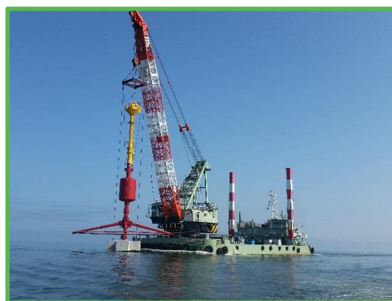
設置作業の様子
