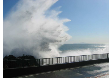
晴天でも越波が発生した例
