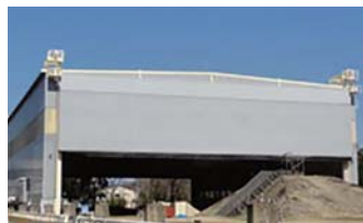
大型降雨実験施設
