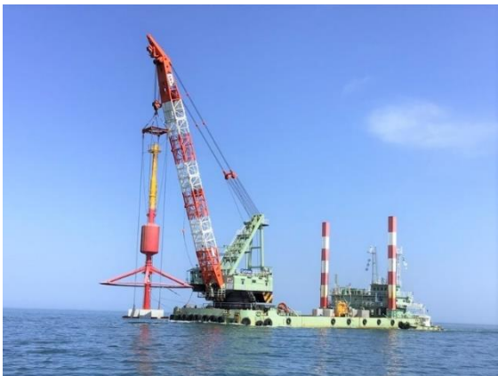
BuoyLidar の設置作業の様子（左）、観測内容（右）
