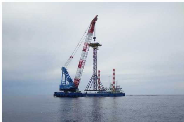
海底地盤調査 (起重機船でのボーリング足場の設置)
