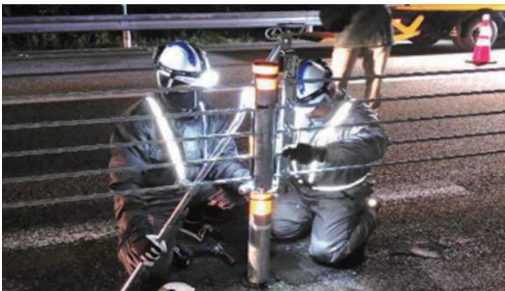
ワイヤロープ解放区間端部支柱の固定金具設置
