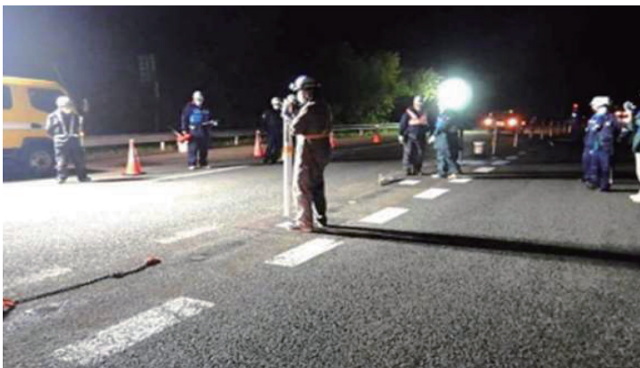
支柱を抜き取る
