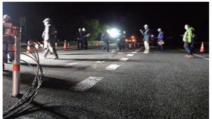
ワイヤロープ中央分離帯の取り外し解放完了 5スパン×4m=20m
