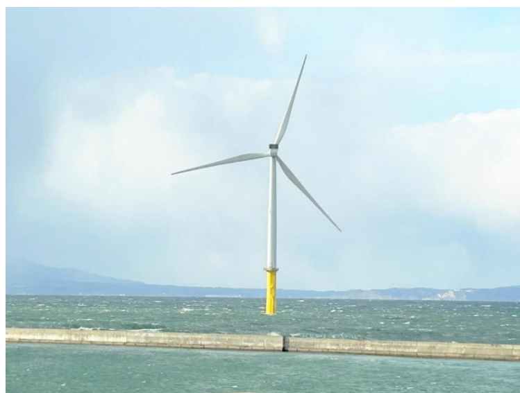
調査対象の風力発電機
