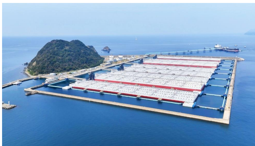
2026年3月に国家備蓄石油が放出された基地のひとつ、白島国家石油備蓄基地 写真提供：JOGMEC
